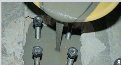
> au sol, couler le mortier de consistance coulis, régulièrement, en évitant toute inclusion d'air > la pièce peut être placée avant ou immédiatement après le coulage du mortier. Elle doit rester immobile pendant la prise du mortier > le produit peut également être utilisé au mur et au plafond
