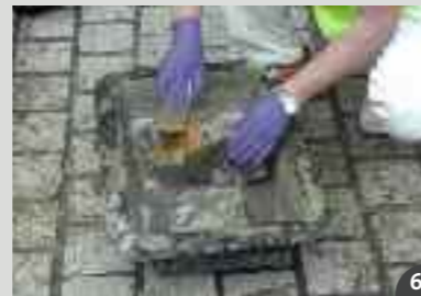
6 > les pavés doivent être propres et humidifiés
