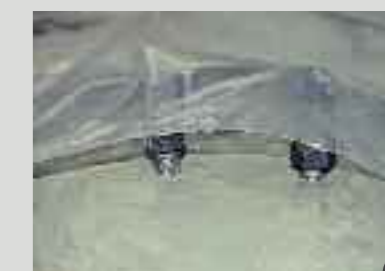
9 > après mise en place, maintenir humide la surface du mortier pendant au moins 24 heures, par application d'une feuille de plastique ou en réalisant une cure par pulvérisation de weber curing
