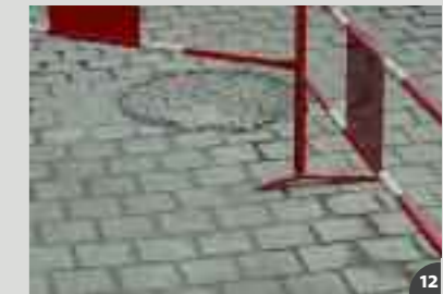
12 > protéger de toute circulation pendant 12 à 48 heures selon le type de trafic et les conditions climatiques
