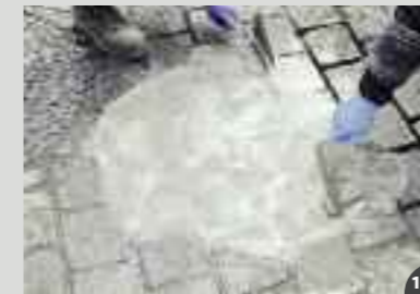
10 > humidifier les pavés > étaler weber.joint pavé à la raclette ou à la truelle en remplissant complètement le joint
