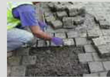
8 > affermir les pavés dès la mise en place à l'aide d'un maillet
