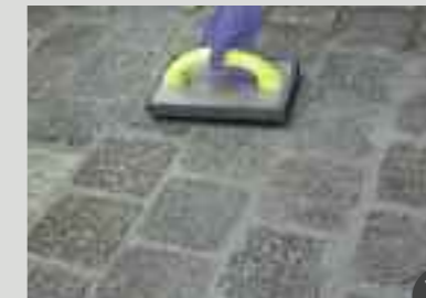
11 > nettoyer au jet d'eau ou à la taloche éponge > évacuer l'eau résiduelle
