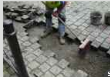
5 > dépoussiérer et nettoyer le support > humidifier abondamment et laisser ressuyer
