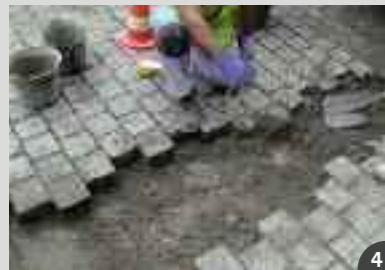
4 > le support doit être propre et cohésif > lors de la réparation, décaisser jusqu'au support solide. Éliminer par piquetage les parties défectueuses
