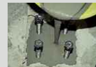
8 > au sol, couler le mortier de consistance coulis, régulièrement, en évitant toute inclusion d'air > la pièce peut être placée avant ou immédiatement après le coulage du mortier. Elle doit rester immobile pendant la prise du mortier > le produit peut également être utilisé au mur et au plafond
