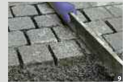
9 > régler les pavés à l'avancement
