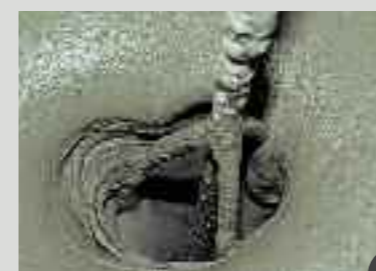
7 > gâcher motex fix SC 125 NF à l'aide d'un malaxeur électrique lent (300 tr/min), jusqu'à obtention d'un mortier homogène - consistance coulis : 4 l/sac de 25 kg - consistance mortier : 3 l/sac de 25 kg > respecter le dosage en eau
