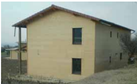
► Complément d'isolation thermique par l'extérieur avec AGEPAN THD sur M.O.B.
