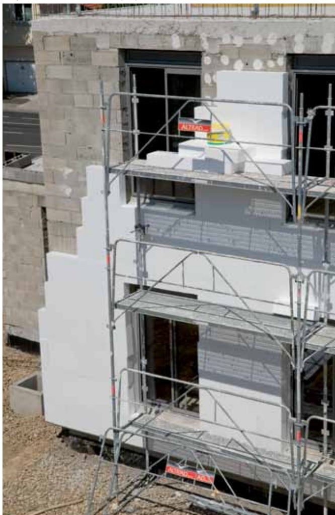
► Système d'isolation thermique par l'extérieur avec P.S.E. blanc
