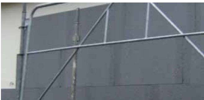
► Système d'isolation thermique par l'extérieur avec P.S.E.gris
