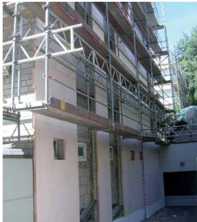
► Système d'isolation thermique par l'extérieur avec isolant weber.therm ultra 22
