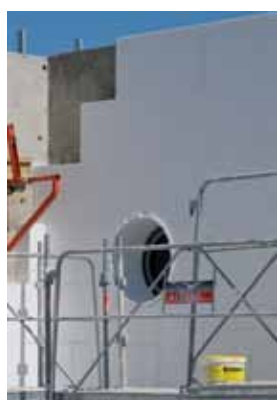
► Une double peau pour isoler le bâtiment
