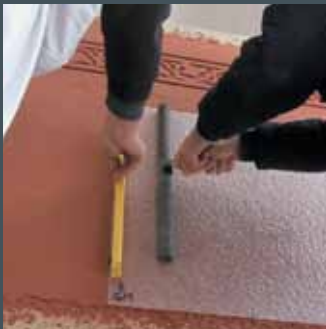
► Application d'une matrice pour ; imprimer des effets de surfaces
