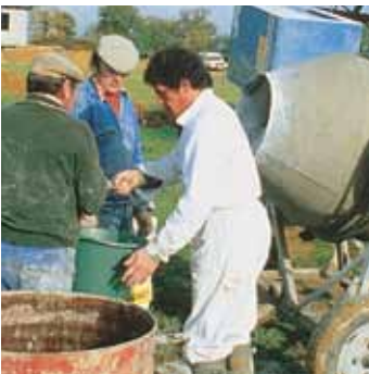
► Préparation manuelle, malaxage à la bétonnière
