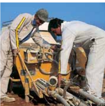
► Préparation avec une pompe à mortier
